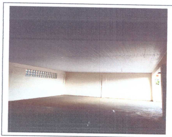
FORRO DE PVC
