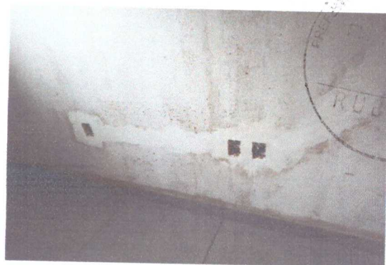
INSTALAÇÃO DE PONTOS DE TOMADA
