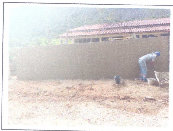
EMBOÇO DO MURO
