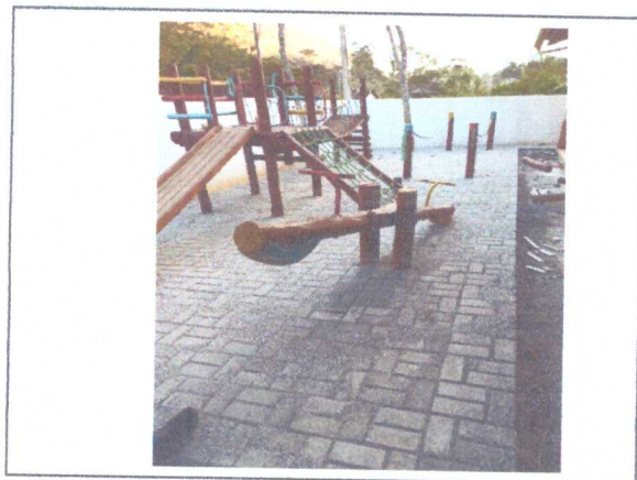
ASSENTAMENTO DE INTERTRAVADO
