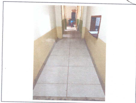
ASSENTAMENTO DE PISO
