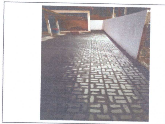
ASSENTAMENTO DE INTERTRAVADO
