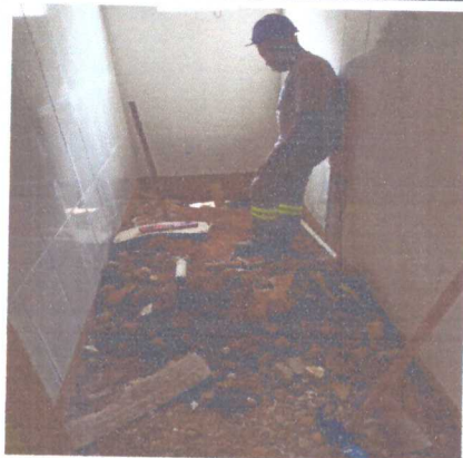
INSTALAÇÃO DE REDE AGUA FRIA E ESGOTO
