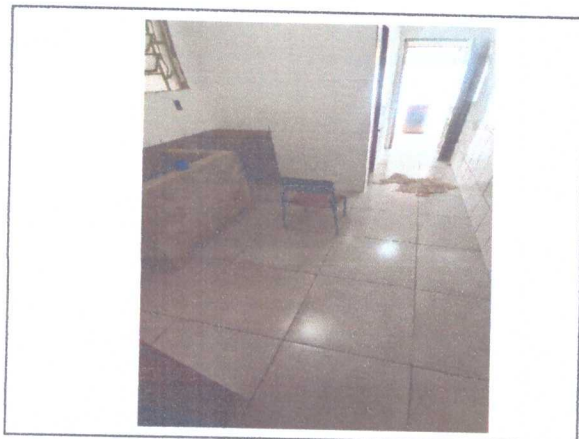
ASSENTAMENTO DE PISO
